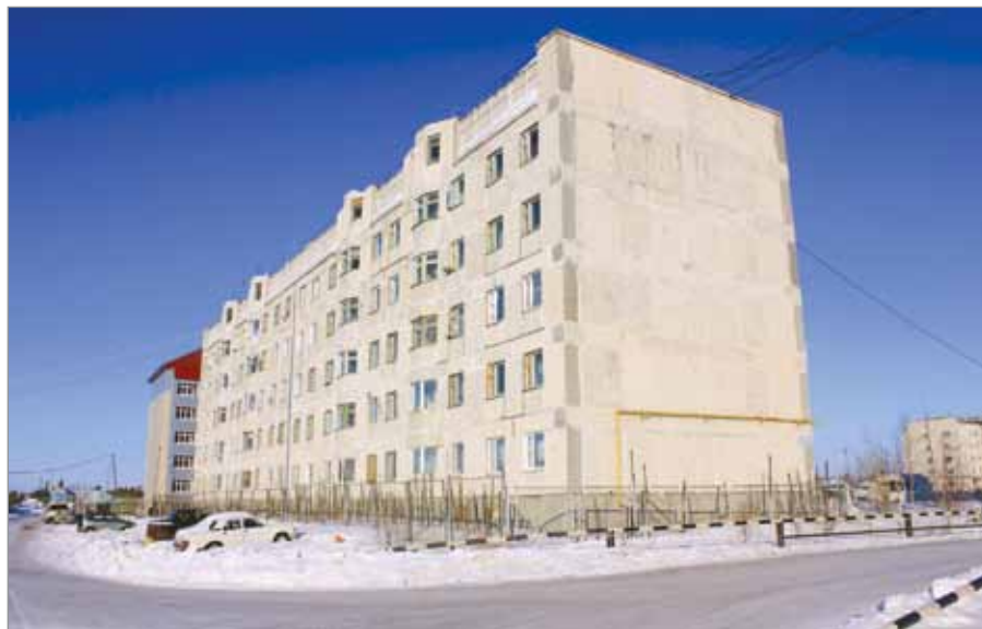
Рис. 4.23 Надым, ул. Топчева, д. 10. Расположенные по периметру зда- ния металлические трубы используют для заморажива- ния грунта в лет- ний период
